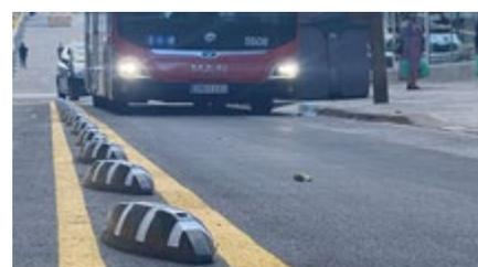
Nuestro **separador vial pantera** puede ser instalado en vías rectas como en vías curvas proporcionando siempre protección a los ciclistas.
